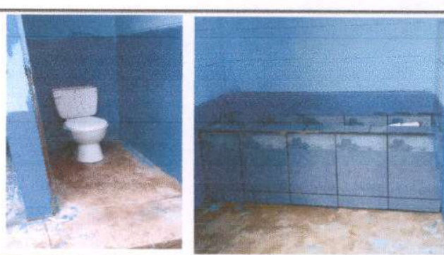
Foto 6: Cambio de baños
