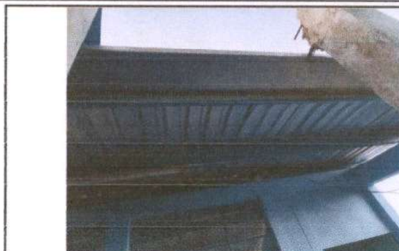
Foto 2: Cambio de canales por deterioro
