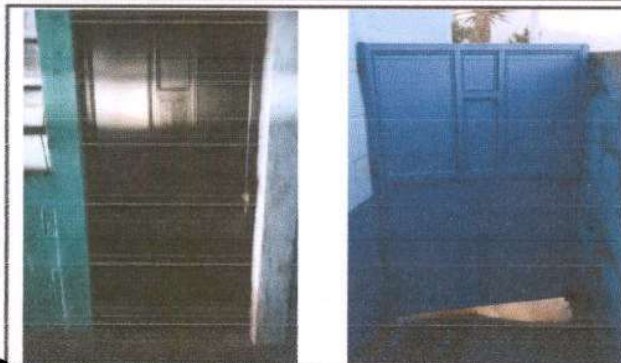
Foto 1: Cambio de puertas
